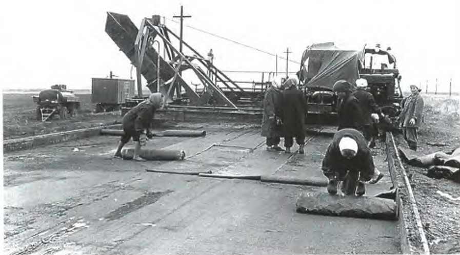
Строительство дорог НКНХ. Бетонукладочный комплекс начала 60-х
