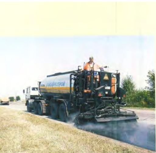
Работает гудронатор с электронной системой контроля объема розлива битумной эмульсии
