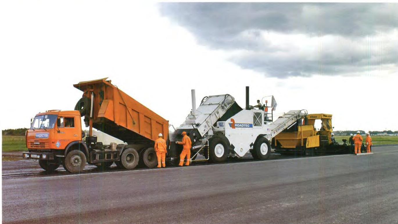
Устройство асфальтобетонного покрытия с применением перегрузочной машины «SHUTTLE-BUGGI SB 2500С»
