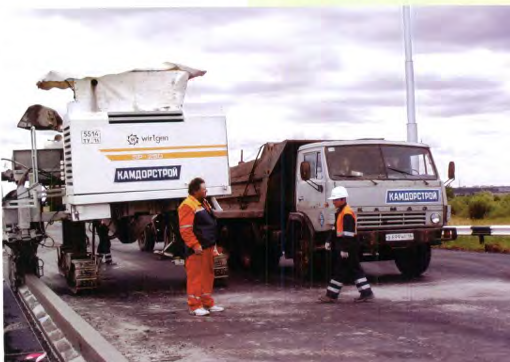
На строительстве дорог СЗС «Алабуга»
