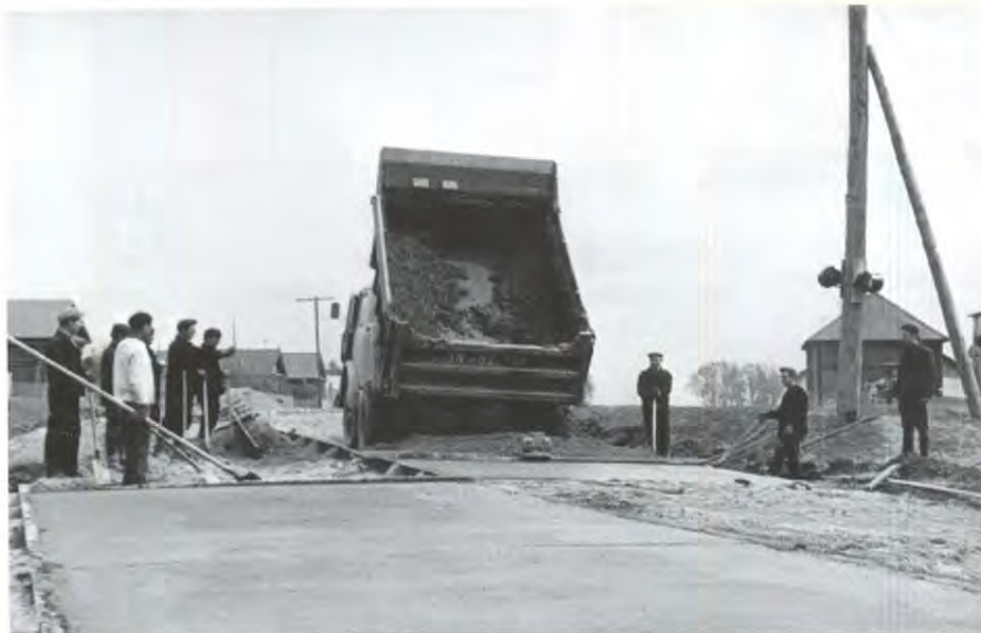
Укладывается бетонное основание дороги. Начало 70-х
