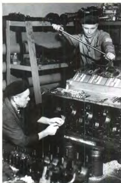
Ремонтная служба АБ-48
