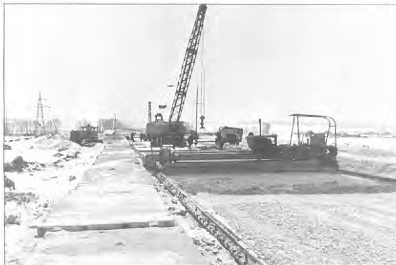
Автодорога №1. Устройство покрытия на ПАТ-14. 1969 год
