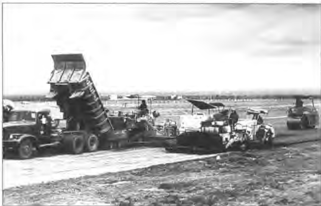
Работает специализированный прорабский участок
