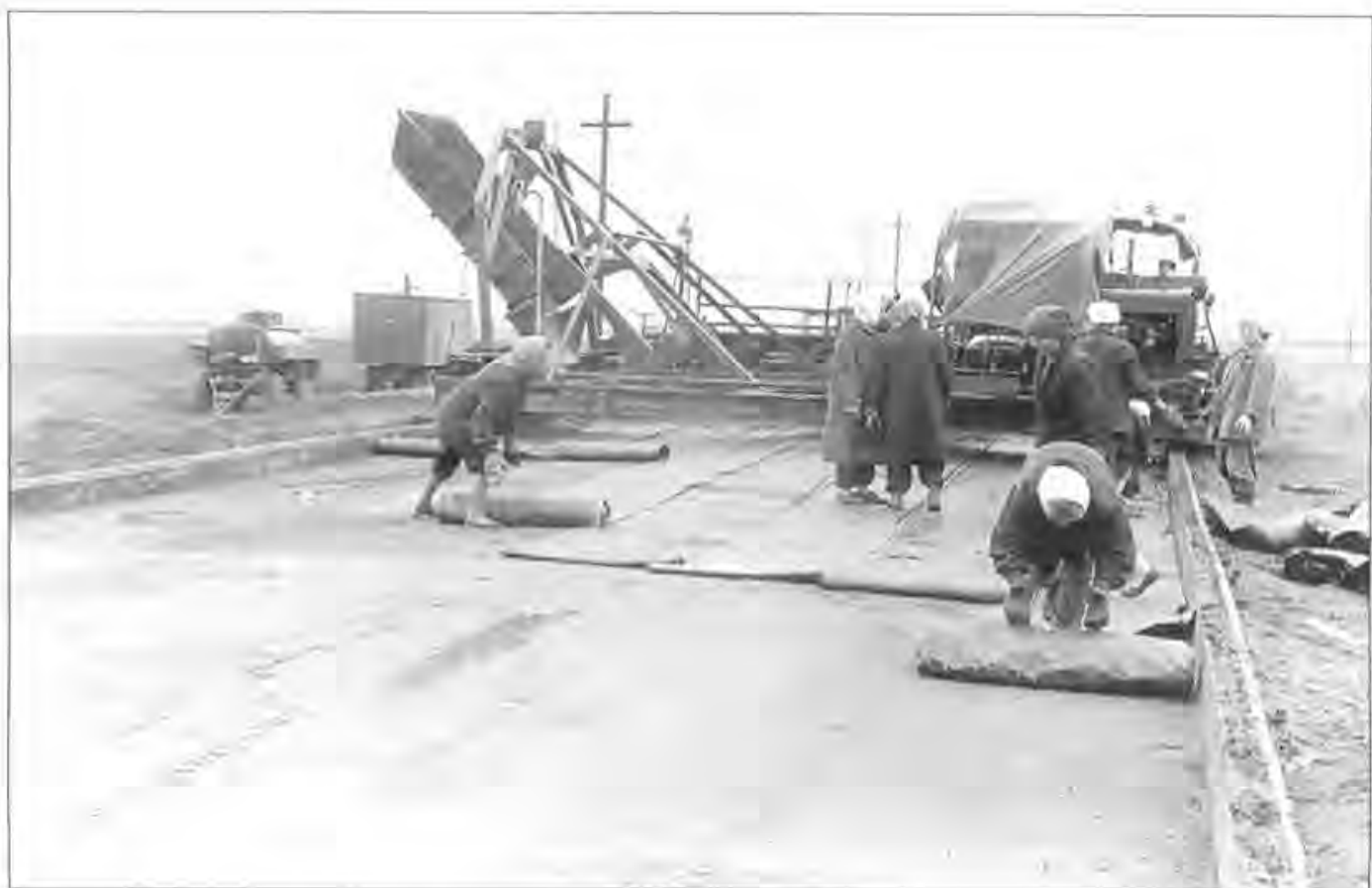
Бетоноукладочный комплекс на ямале 60-х. Строительство дорог НКХ.
