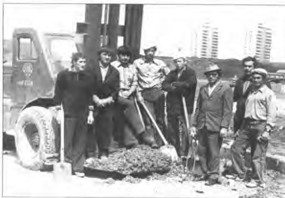
Бригада по установке бортового камня Ф. Каленного.
